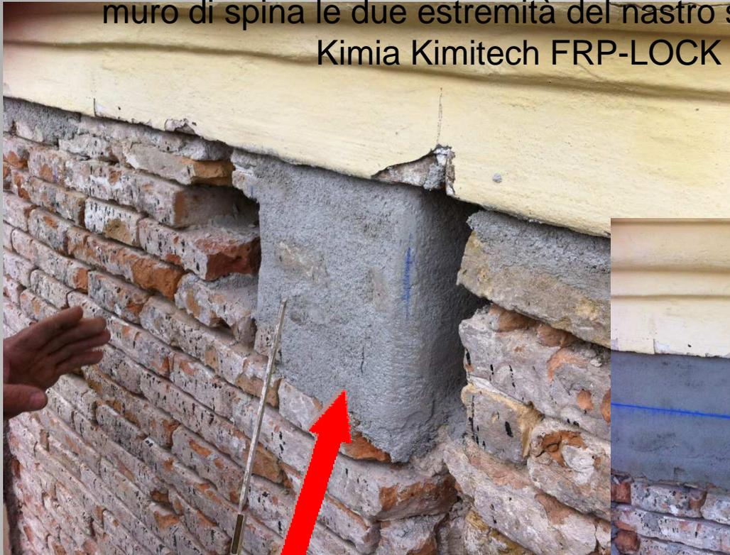
*Preparazione del supporto per la stesa del tirante in CFRP*
