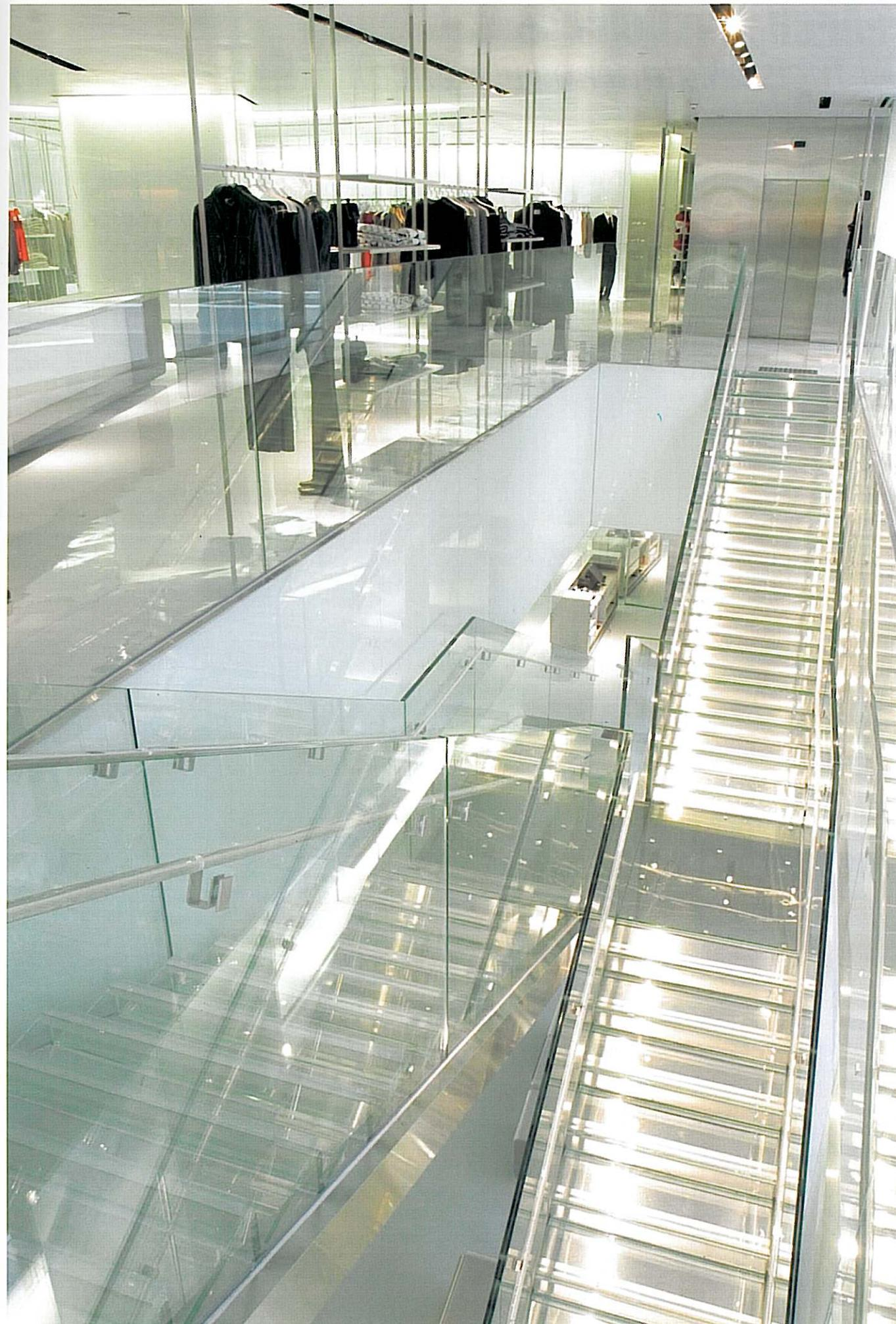
Particolare della scala, composta da due lame d'acciaio sormontate da gradini di vetro; il corrimano è in acciaio ricoperto da un tubolare in plexiglass.
